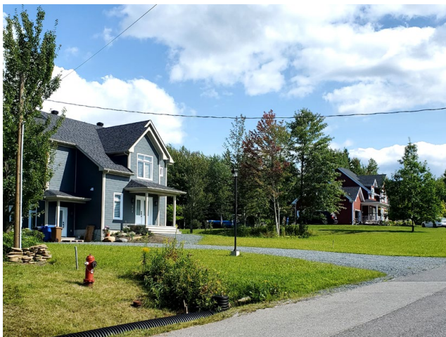
Des résidences dans le secteur du Haut-Bois Enclume
