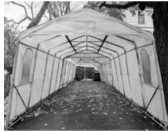
4- Les abris d'hiver ou garage temporaires doivent être fabriqués en toile ou en matériel plastique monté sur une ossature métallique ou de plastique synthétique conçue pour ce genre de construction.
